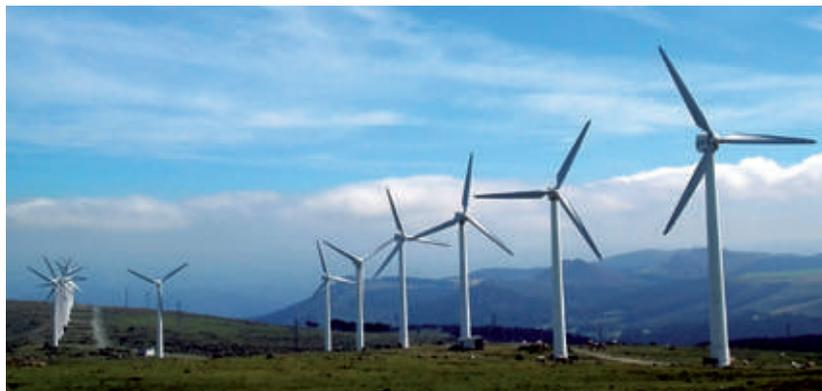
Las aspas del molino van conectadas a un eje, que hacen girar un sistema de engranajes, que están conectados al eje de un generador corriente. Cuanto más alta sea la velocidad del viento, más rápido girará el eje y más corriente eléctrica se producirá, razón por la cual las torres de estos generadores son muy altas, entre 30 o 50 metros de altura.
