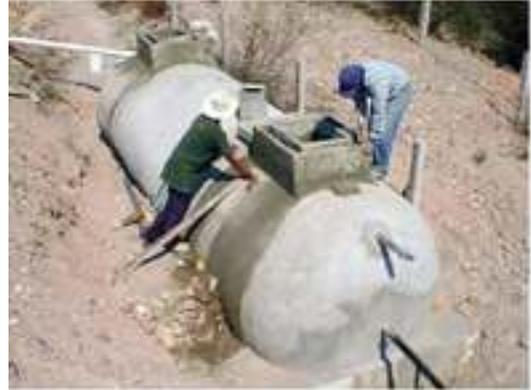
Se utiliza para la conservación del material orgánico que se tiene en los lodos biológicos producidos en el proceso de tratamiento de las aguas residuales.
